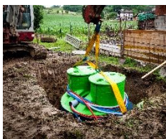
Vstavljanje ČN v gradbeno jamo
