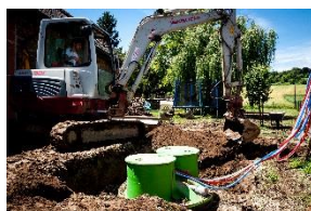
Priprava zračnih cevi za vstavev v zaščitno cev – Stigmaflex
