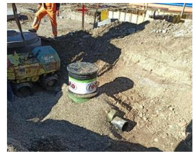
Bild 8: Verfüllen der Baugrube mit Kies 4 – 16 mm
